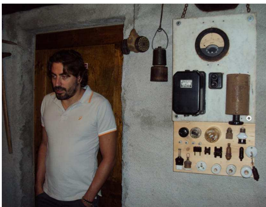
Vecchio quadro elettrico dotato di strumento Amperometro a lato Paolo
